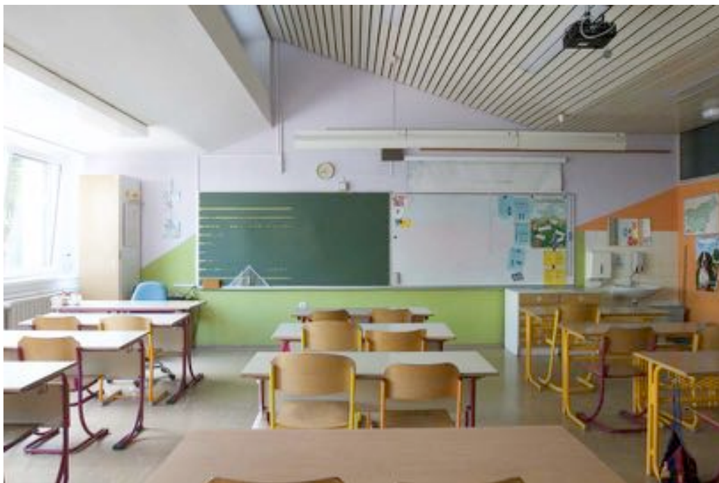
Slika 11: Pogled na sprednjo steno obstoječe učilnice
