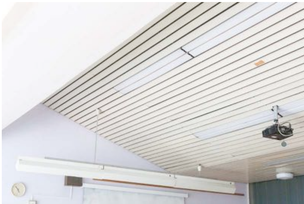
Slika 52: Strop obstoječe učilnice
