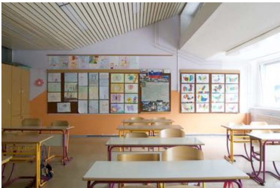
Slika 10: Pogled na zadnjo steno obstoječe učilnice
