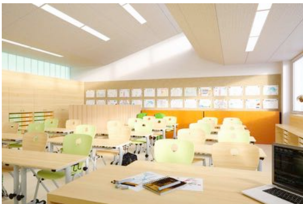
Slika 53: Strop prenovljene učilnice
