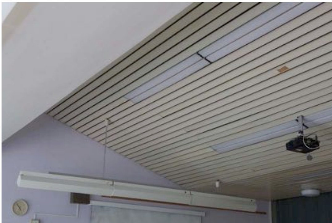
Slika 12: Strop obstoječe učilnice
