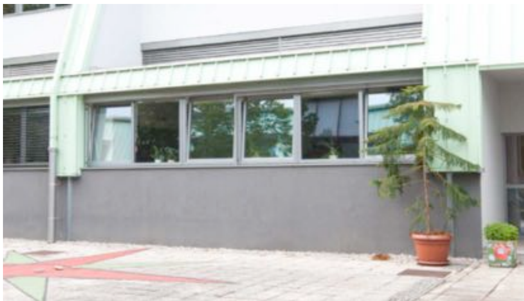
Slika 49: Pogled na obstoječo učilnico od zunaj
